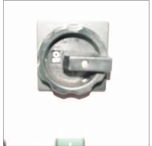
7) Elektr. Hauptschalter einschalten
