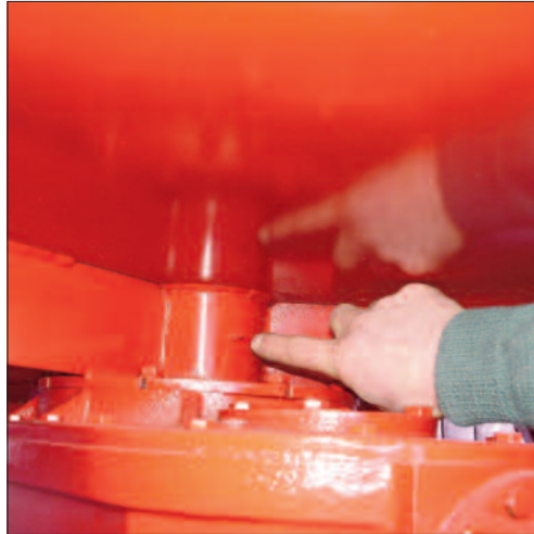
1) Schmierstelle Mischkreuz unten kontrollieren/nachfetten
